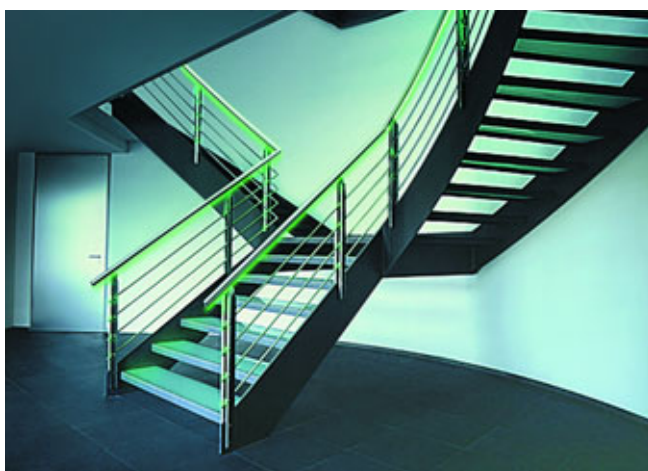
Bild 38: Licht in den Handläufen – LEDs machen es möglich.
